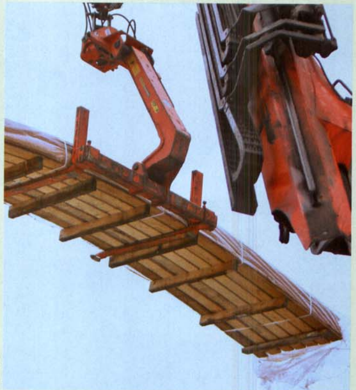
Die WPC-Terrassendielen können per Hochkran direkt an ihren Verarbeitungs-ort transportiert werden.
