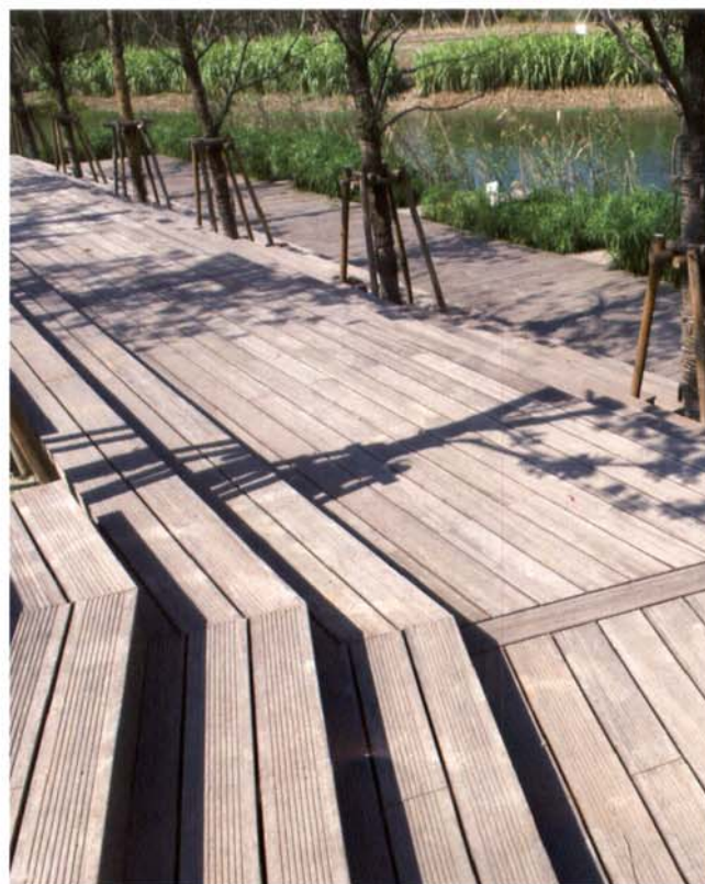
Terrassendielen aus Thermo-Bambus. Witterungseinflüsse verursachen einen typischen Grauton, wie er auch von tropischen Hölzern bekannt ist.
