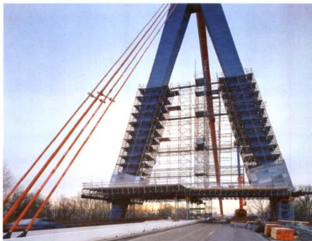
Spannender Gerüstbau für Korrosionsschutzarbeiten in Speyer.
